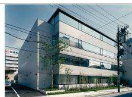
オフィスビル建設工事
