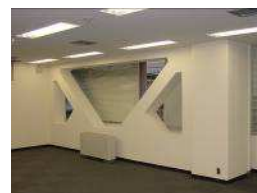
耐震補強工事施工例
